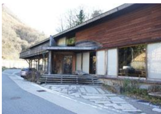
木曽アルテック本社外観
